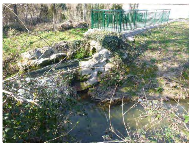
le rejet de la station d'épuration de Gardanne
