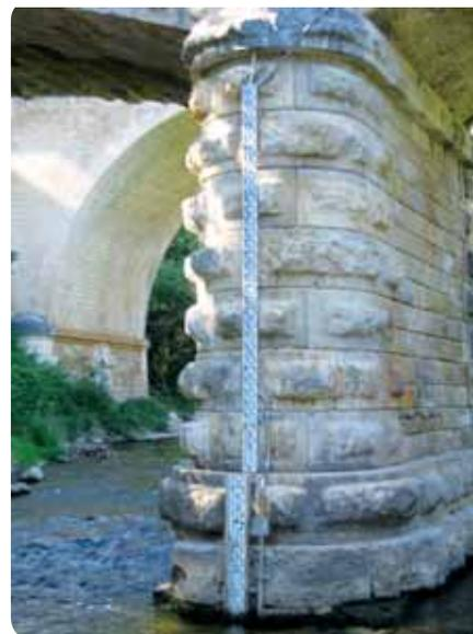
Échelle de mesure de hauteur sur l'Arc à Roquefavour (Aix-en-Provence)
